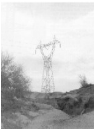
Les línies exteriors poden provocar incendis i les instal·lacions interiors també.
