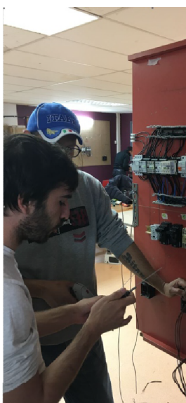
FOAP: Alumnes realitzant un quadre electric d'una instal·lació
