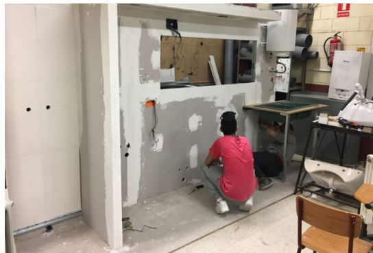
JOVES PER A L'OCUPACIÓ: Alumnes simulant la instal·lació elèctrica d'una cuina
